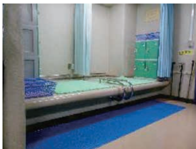
写真3-5-2-1：造り付けの移乗台
