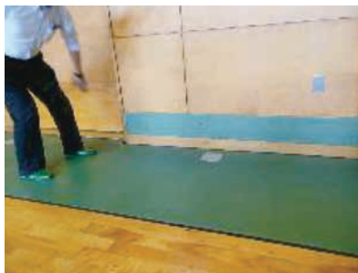
写真3-5-1-1：体育館の巾木
