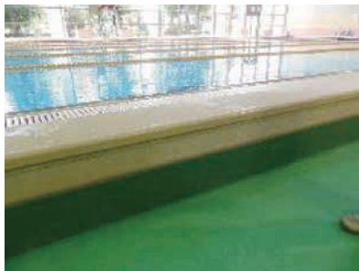
写真3-5-1-5：かさ上げされたプールの縁
