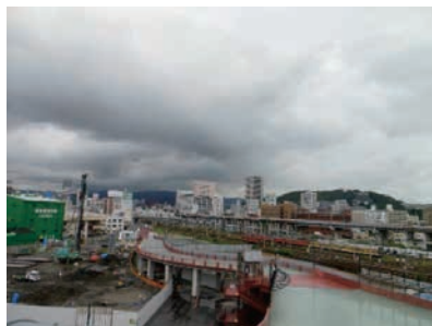
写真2-9-2-1：マツダスタジアムのスロープ
